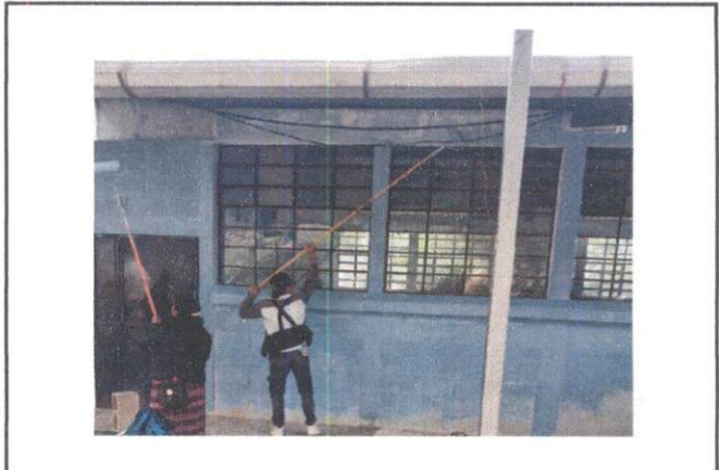
Foto 4: Mejoramiento Pintura General
