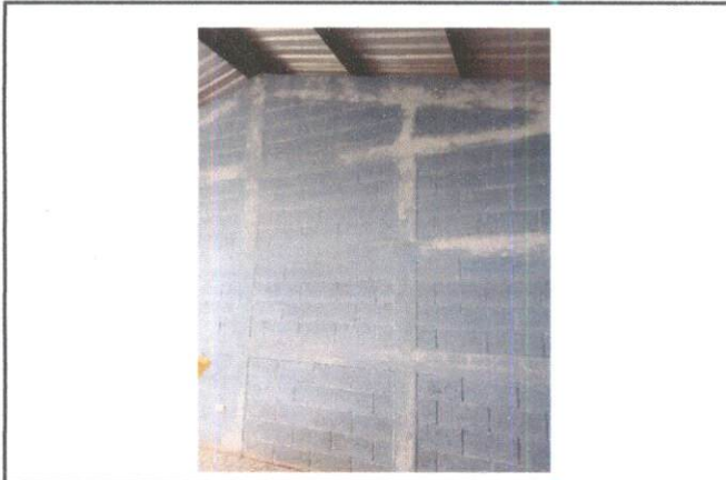
Foto 3: Mejoramiento de Pintura General
